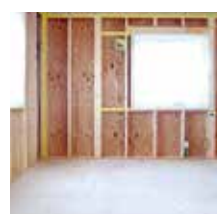
吹付けスペースを確保
