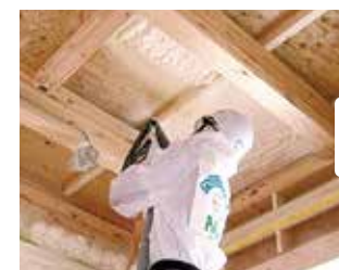
fig.03 吹付けの様子
