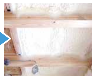
fig.04 吹付け完了後
