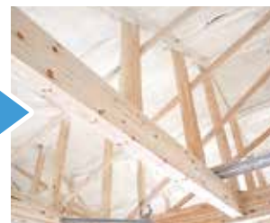
fig.02 吹付け完了後
